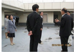
長沼施設長の説明に耳を傾けられていた。
