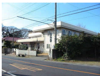
婦性会全景 国道 5 1 号線に面しているのです
