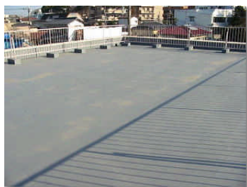
婦性会の屋上 工事が完成しました
