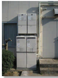
お風呂の機能UP 大型室外機です。電気温水器からガスによる追い焚きができるようになりました。
